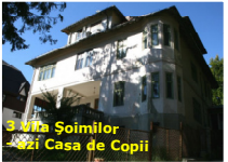
3 Casa Soimilor, azi Casa de Copii Vila Soimilor - azi Casa de Copii cod L.M.I. 2015: PH-II-m-B-16682 adresă: Sinaia, str. Take Ionescu, nr. 1 datare: sf. sec. XIX - inc. sec. XX, stare precară de conservare
